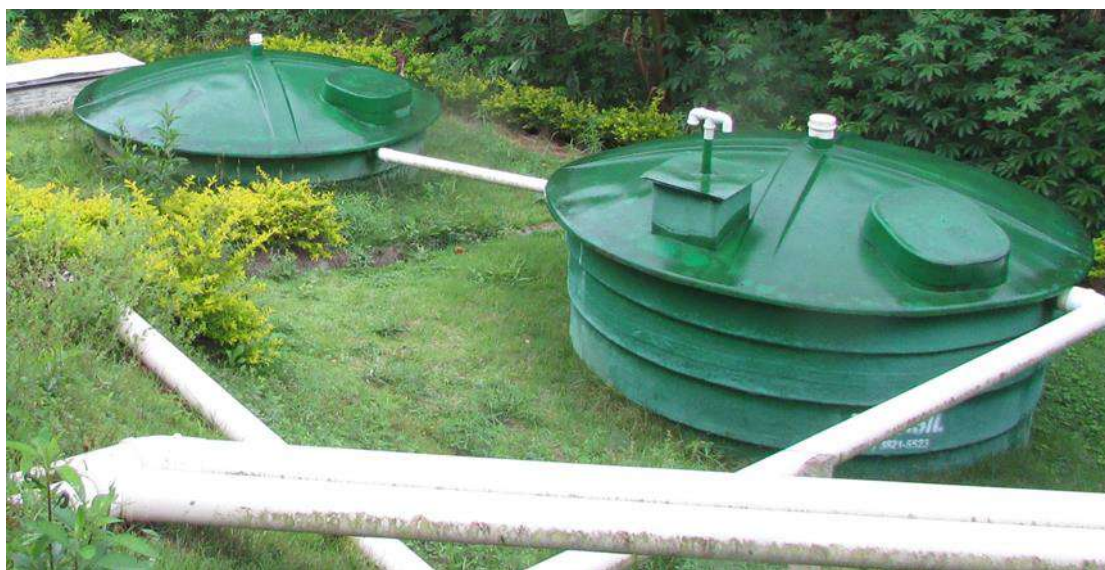
Figura 1. Sistema de Tratamento de Águas Residuárias composta por reator UASB seguido de Filtro Anaeróbio. Fonte: Acervo do autor.
